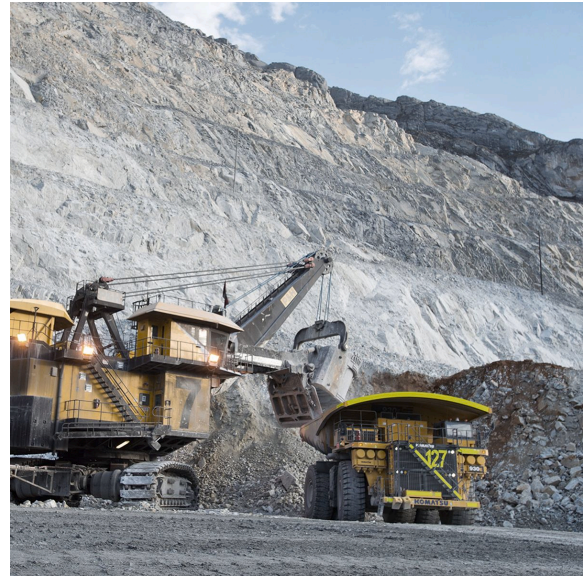
SILVER ORE, PERU Source: desde adentro [ https://www.desdeadentro.pe/2022/04/los-retos-de-construir-las-proximas-minas/ ]
