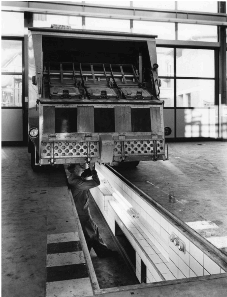
Power station Josefstrasse. Source: Baugeschichtliches Archiv, 1940.
