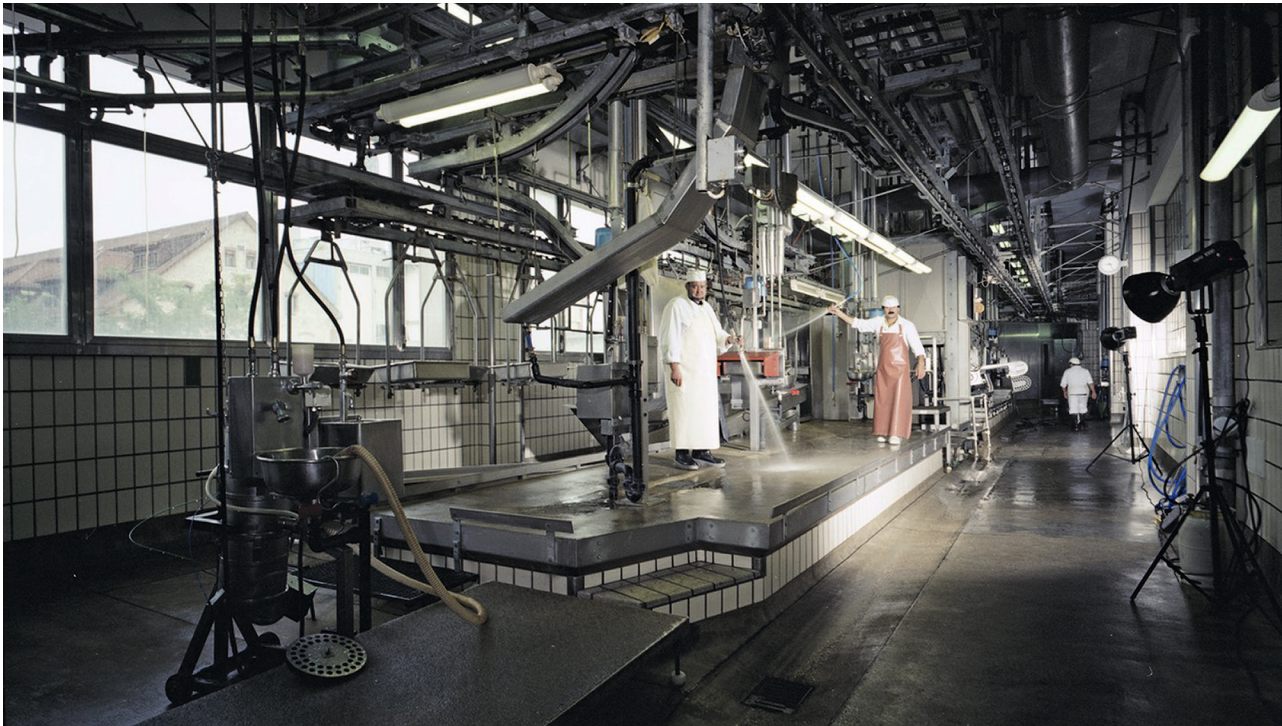
Schlachthof Zürich, 1993. (Photo: Peter Morf © Baugeschichtliches Archiv, Stadt Zürich)
