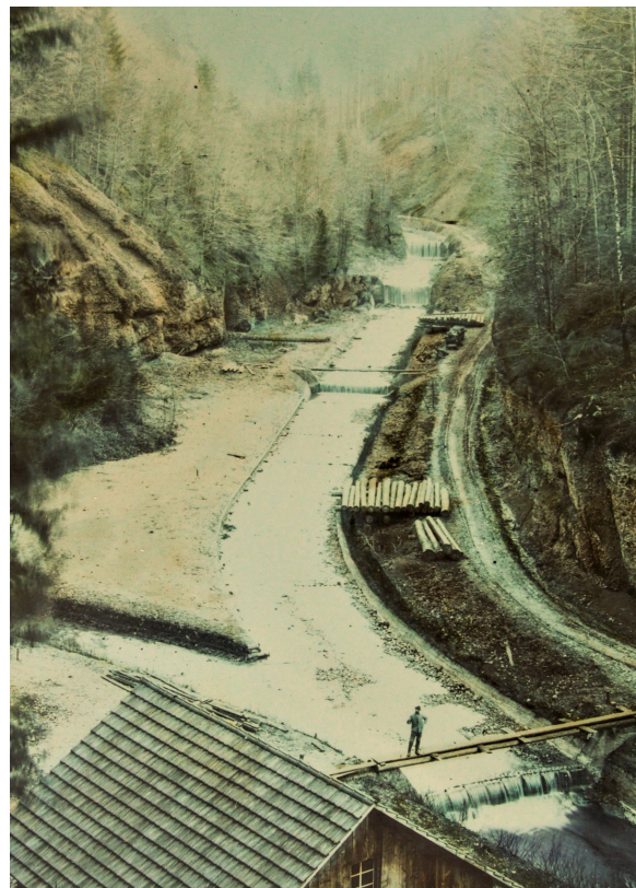
Tösswald Canalization Tössscheide
