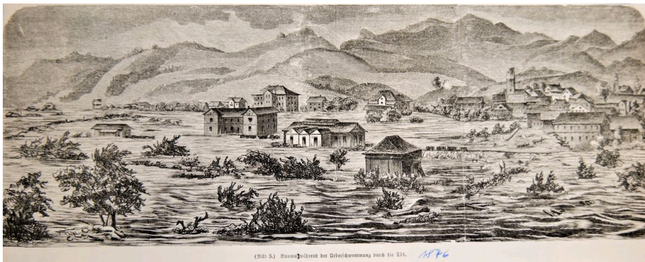
1876 Bauma während einem Hochwasser
