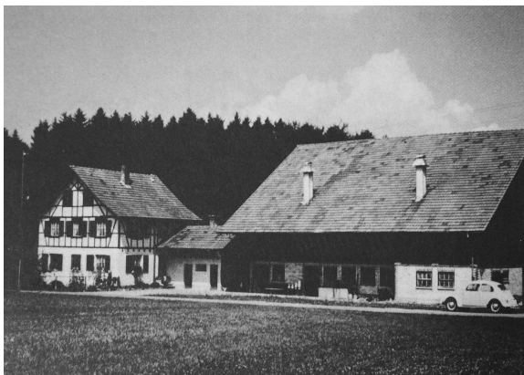
Settlement Rasi in Buechrüti.
