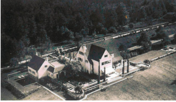
Grieder House, 1928. Source: Wohnort: 8126 Zumikon, 2009.
