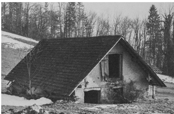
FORMER COMMUNAL BUILDING IN HIRZEL-CHALBISAU, 18TH CENTURY. Source: Renfer, Christian, Die Bauernhäuser des Kantons Zürich. Band 9-11 . Basel: Schweizerische Gesellschaft für Volkskunde, 1982.
