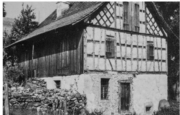
FORMER COMMUNAL BUILDING IN HIRZEL-SITEN. Source: Winkler, Jürg, Der Hirzel. Bild einer Gemeinde . Hirzel: Jürg Winkler, 1989.
