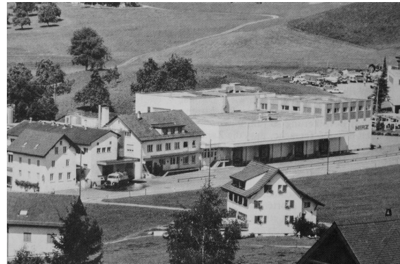
EXPANSION OF HIRZ FACTORY, 1984. Source: Winkler, Jürg, Der Hirzel. Bild einer Gemeinde . Hirzel: Jürg Winkler, 1989.
