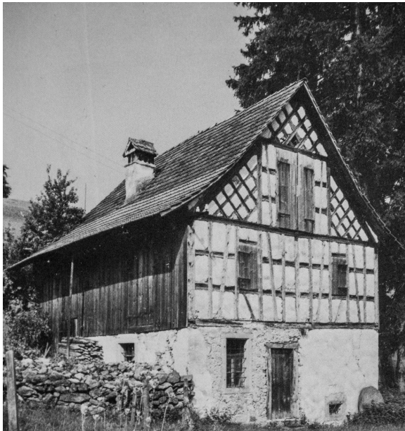
FORMER COMMUNAL BUILDING IN HIRZEL-SITEN. Source: Winkler, Jürg, Der Hirzel. Bild einer Gemeinde . Hirzel: Jürg Winkler, 1989.
