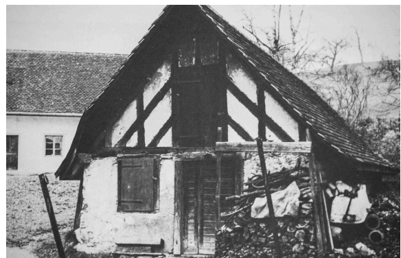
FORMER COMMUNAL BUILDING IN HIRZEL-KIRCHE. Source: Winkler, Jürg, Der Hirzel. Bild einer Gemeinde . Hirzel: Jürg Winkler, 1989.
