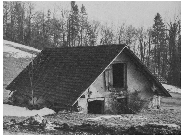
FORMER COMMUNAL BUILDING IN HIRZEL-CHALBISAU, 18TH CENTURY. Source: Renfer, Christian, Die Bauernhäuser des Kantons Zürich. Band 9-11 . Basel: Schweizerische Gesellschaft für Volkskunde, 1982.
