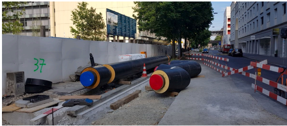
Laying Pipes In the Ground. Source: Stadt Zürich, 2022. [ https://www.stadt-zuerich.ch/energie/de/index/heizenkuehlen/fernwaerme.html ]
