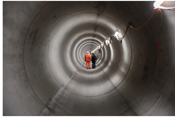
In the Underground. Source: Tagesanzeiger, 2020. [ https://www.tagesanzeiger.ch/milliardenprojekt-fernwaerme-so-treibt-zuerich-den-ausbau-voran-600003489948 ]
