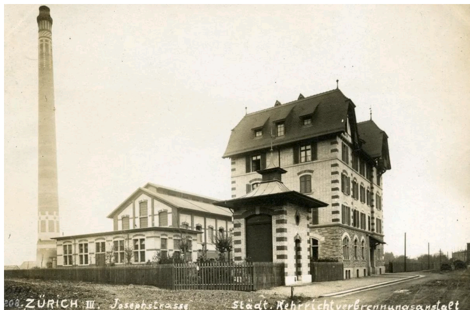
Waste Disposal Centre Josefstrasse. Historical Image from 1907. Source: Baugeschichtliches Archiv, 2023. [ https://baz.e-pics.ethz.ch/catalog/BAZ/r/193235/viewmode=infoview/qsr=kehrichtverbrennung%20josefstrasse ]
