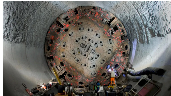
DRILLING MASCHINE TO CREAT THE TUNNEL (Source: Swissinfo, Das Leben der Bauarbeiter im Gotthard-Tunnel)
