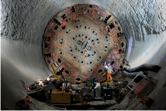
Drilling Maschine to create the Tunnel Source: Swissinfo, Das Leben der Bauarbeiter im Gotthard-Tunnel
